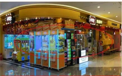
大型商场内设游艺厅、儿童活动场所未采取防火分隔
